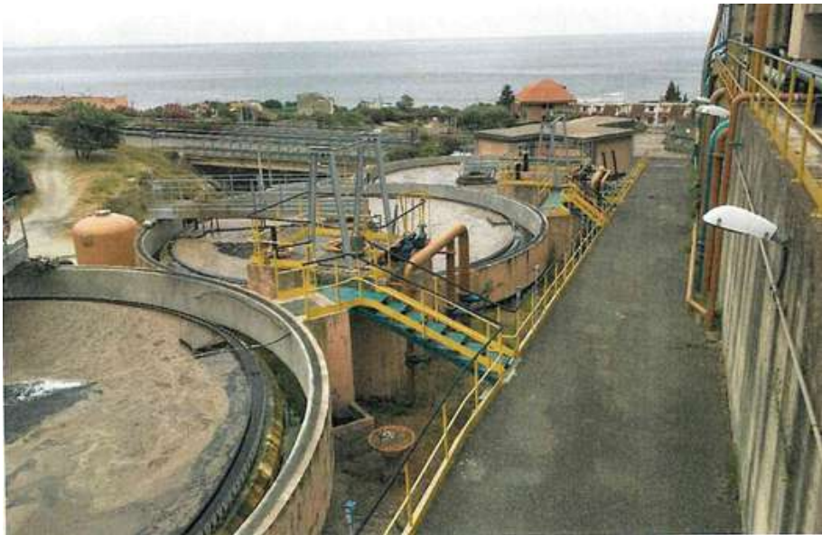
Impianto di Depurazione di Letojanni (ME) – Sedimentatori secondari
