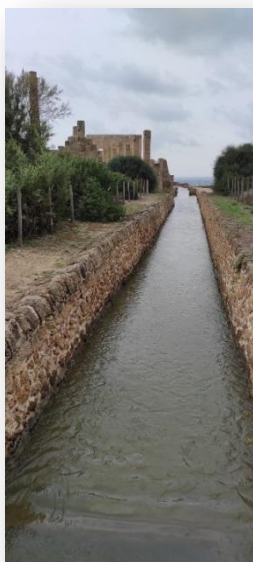
Figura 6.1.2 - Canale di afflusso/deflusso del Pantano Grande
