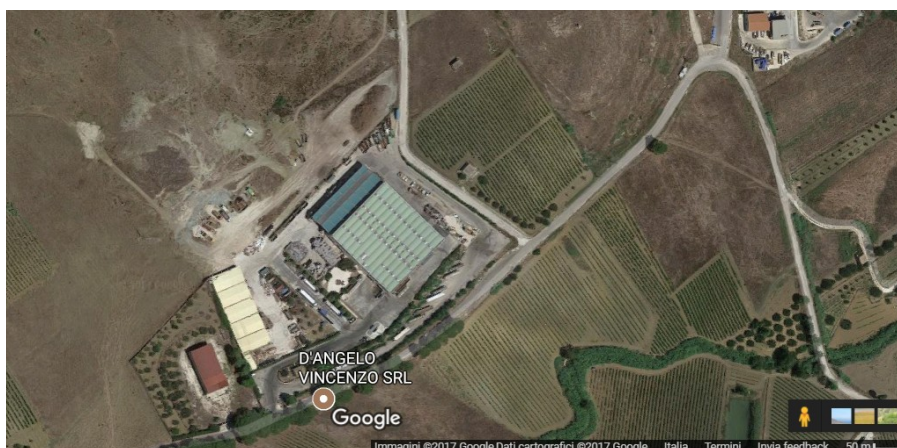
Fig.1 – Particolare del sito.
